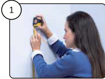
1 Trace las alturas a las cuales instalará los estantes. Mark out desired height at which the shelves will be mounted.
