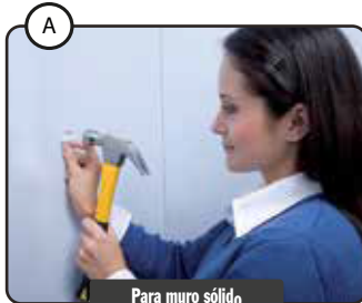
A Para muro sólido For Masonry Wall Martille cuidadosamente el clavo roscado en el "chazo J". Carefully hammer the "screw pin" into the "wall clip".
