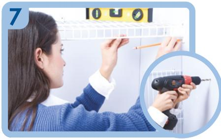
Ubique el "soporte lateral" en el entrepaño, nivele y marque los orificios a perforar con broca de  $\frac{1}{4}$ ". Fije con chazos y tornillos.
